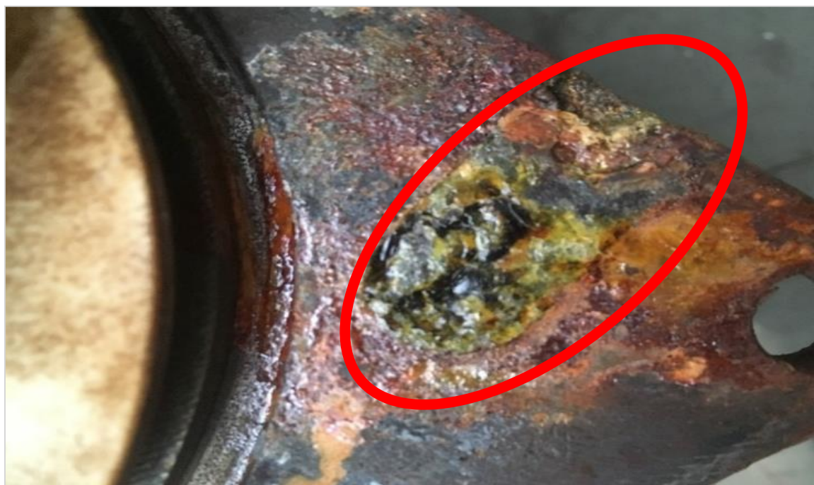
Figura 58: Válvula alívio da bomba d'água obstruída
