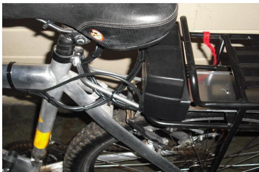
Figura 20 - Conclusão instalação do módulo de controle.
